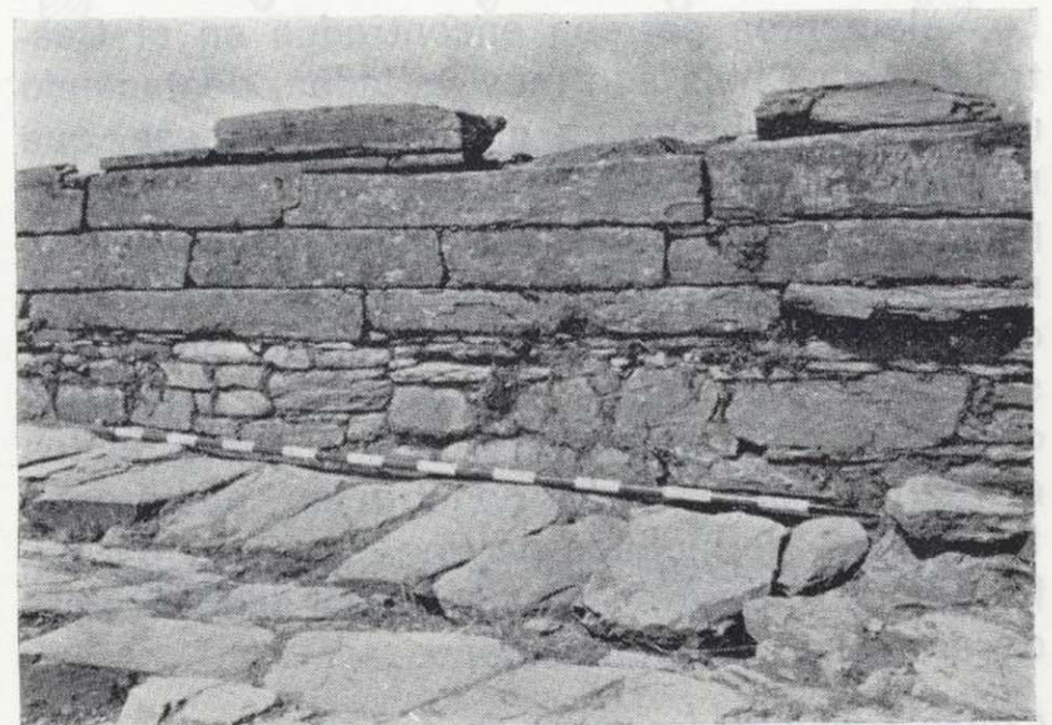
Foto 6.—Detalle de un muro de sillares de arenisca en los que se observan marcas de los cinceles metálicos utilizados para su elaboración.
